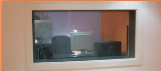
En las instalaciones donde se requiere una comunicación visual entre paredes aisladas, fabricamos una serie de VISORES ACÚSTICOS que se diseñan en función de la atenuación requerida y de las condiciones de uso.
