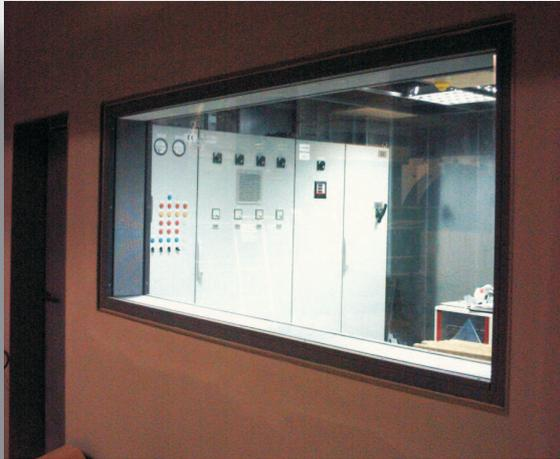
Fabricada mediante una estructura de perfiles de acero de 2 mm. de espesor, que incorporan cristales de 8 y 10 mm de espesor, sujetos a la estructura mediante junquillos metálicos atornillados y con juntas de neopreno para su estanqueidad en todo su perímetro. En interior lo forma una cámara de aire que contiene paneles fono absorbentes terminados en acero galvanizado de alta perforación. Sujeta al paramento mediante soldadura y sellado con masilla de poliuretano.
