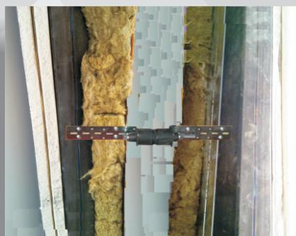
Creado para la formación de tratamientos acústicos flotantes en paredes: desvinculando la pared original del aislamiento.
