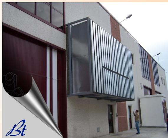
Accesorios bajo pedido, fabricados con chapa de acero galvanizado de 0,8 a 1,2mm de espesor:
