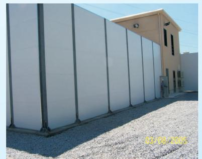
Los paneles BT-Modul 100 están formados por una chapa lisa de acero de 0,6 mm, un núcleo interior de lana de roca rodeado de dos cámaras de aire, y una chapa de acero microestirado de 1 mm. Clasificación al fuego A1 (incombustible). Cumple con los sistemas de protección acústica exigido en carretera y vía férrea.
